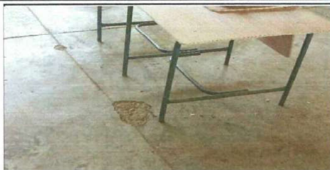
Foto 2: Cambio de torta de cemento a ceramica aula 2
