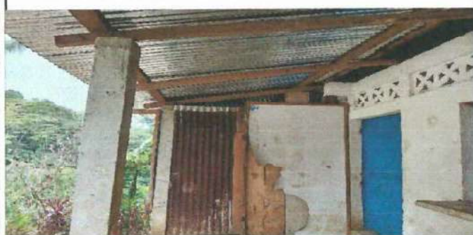
Foto 9: Cambio de madera estructura de techo y levanta la altura del corredor de la cocina
