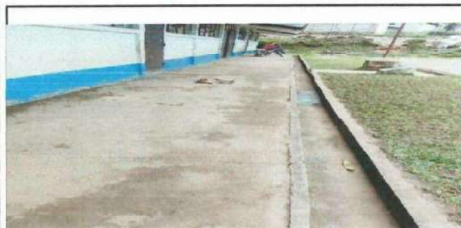
Foto 10: cambio de pintura de muro exterior utilizando pintura de aceite color nacional
