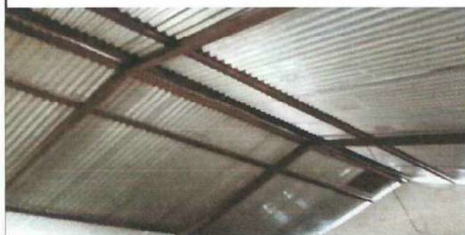
Foto 10: cambio de lamina con lamina troquedalo calibre 26
