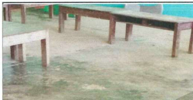
Foto 4: Cambio de torta de cemento a ceramica aula 4
