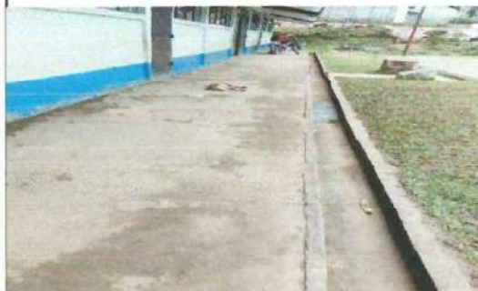
Foto 8: cambio de piso en el corredor de la escuela utilizando piso antedslizante
